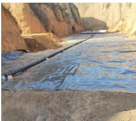
底部防渗膜铺设
