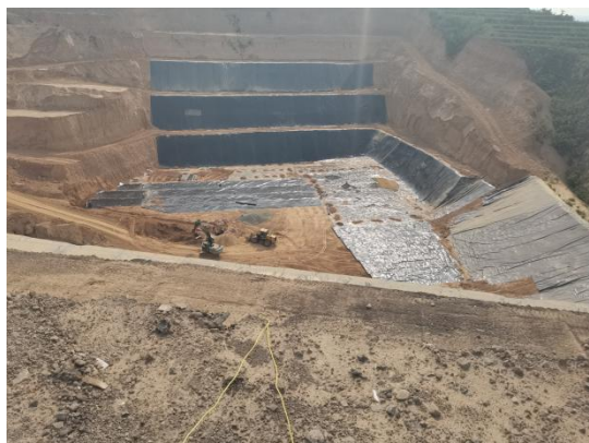
坝坡防渗膜铺设
